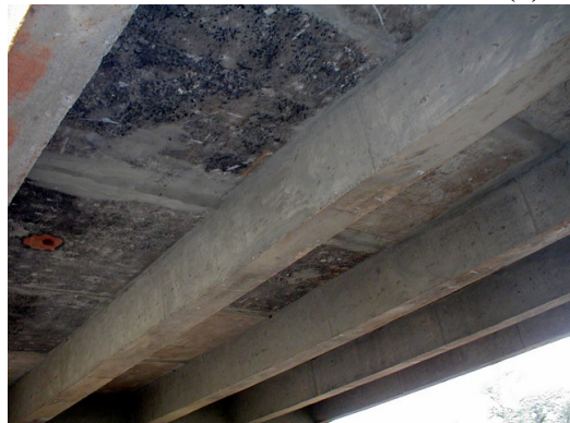
写真 8.50 北回廊小規模スラブ橋 (2)
