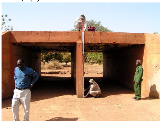
写真 8.42 キタ～カティ間ボックスカルバート (1)
