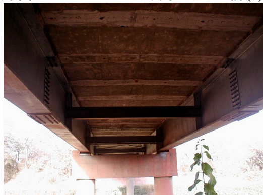
桁間隔は約 6m と広い
