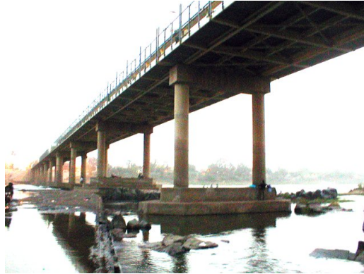
ポン・デ・カイ (カイ橋)
