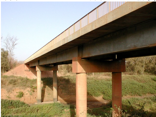
鋼桁 (少数桁) が採用されている
