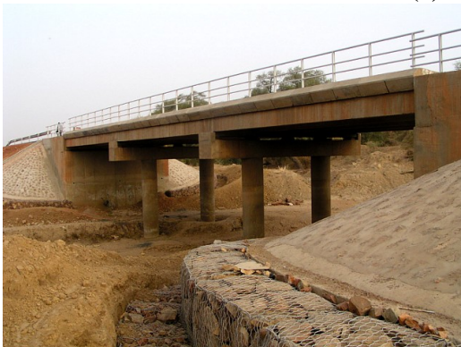
写真 8.49 北回廊小規模スラブ橋 (1)
