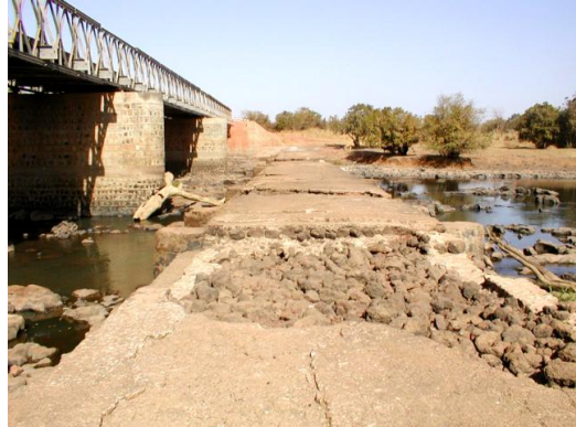
植民地時代に建設された潜水橋，車両は通行できない
