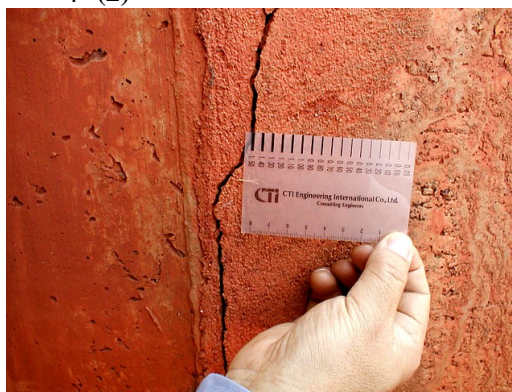
写真 8.43 キタ～カティ間ボックスカルバート (2)
