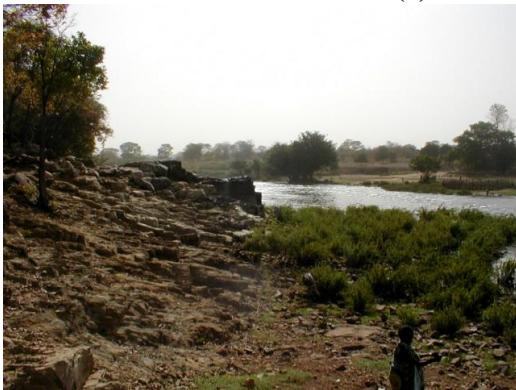
写真 8.5 ファレメ川橋 (5)
