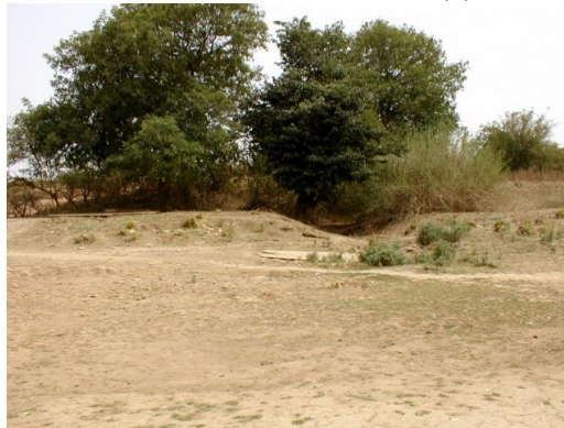
写真 8.4 ファレメ川橋 (4)
