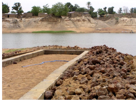
建設中のジェットイピア
