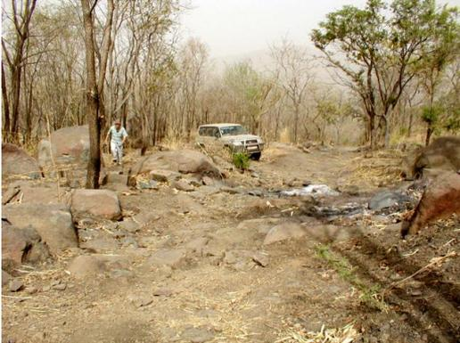
路面に岩石が露出し四輪駆動車でも走行は困難である
