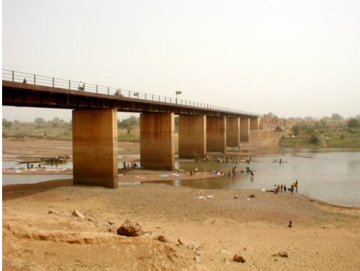
写真 5.1 北回廊国境に架かる橋
