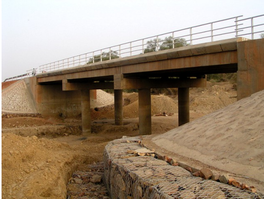
写真 8.49 北回廊小規模スラブ橋 (1)
