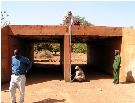
写真 8.42 キタ～カティ間ボックスカルバート (1)
