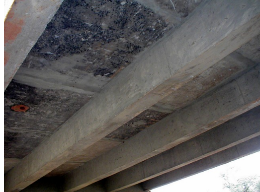
写真 8.50 北回廊小規模スラブ橋 (2)
