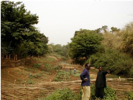
現道交差部より約 100m 下流
