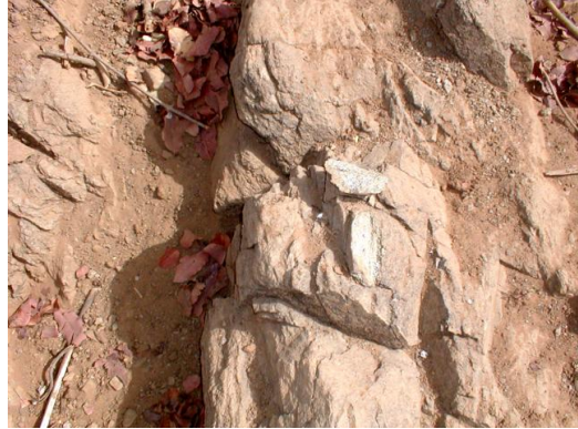
写真 8.6 ファレメ川橋 (6)
