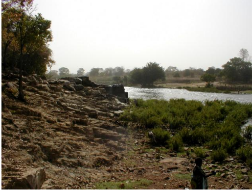
写真 8.5 ファレメ川橋 (5)
