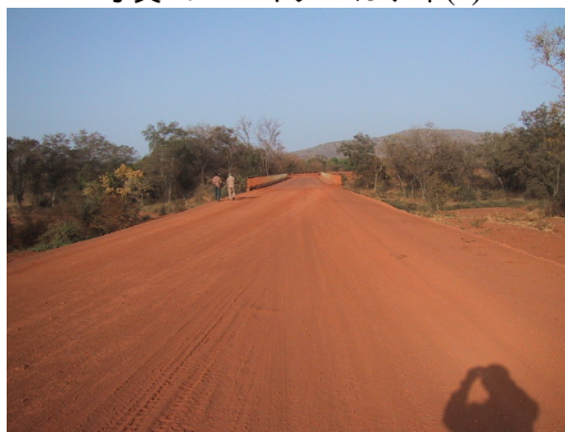
橋梁部手前，橋面はモルタル仕上げであった
