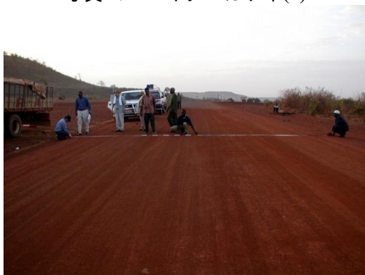
10m 幅員のラテライト道路が整備されている
