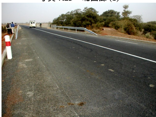
北回廊舗装整備状況(サンダーレ～カイ中間地点)
