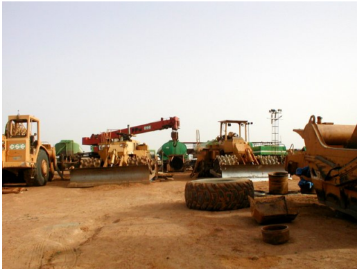
北回廊舗装工事基地
