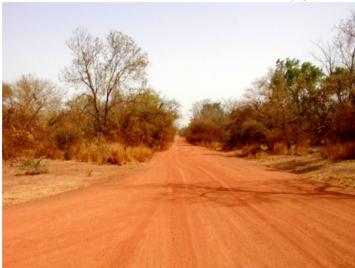
幅員は 7m 程度である
