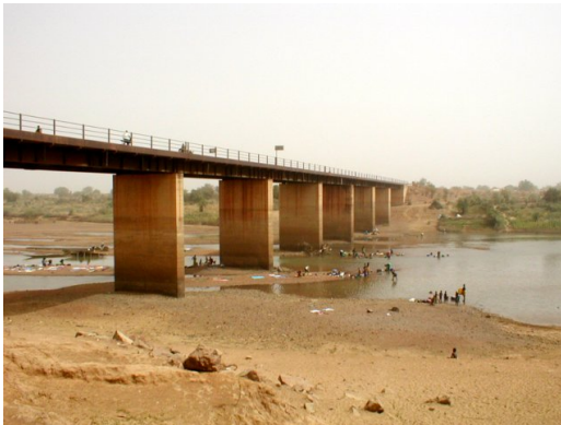
写真 5.1 北回廊国境に架かる橋
