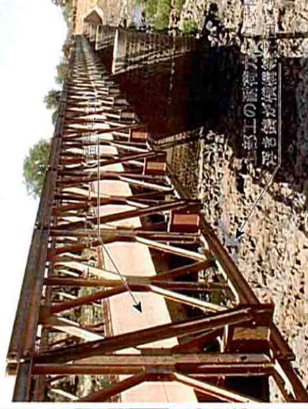
マベイ橋(仮設橋としてよく用いられる組立式簡易橋)ドイツの無償資金協力(KfW)により1999年完成
