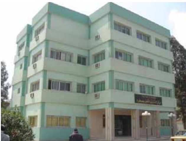
GOGCWSモストロッド訓練センター 研修管理棟
