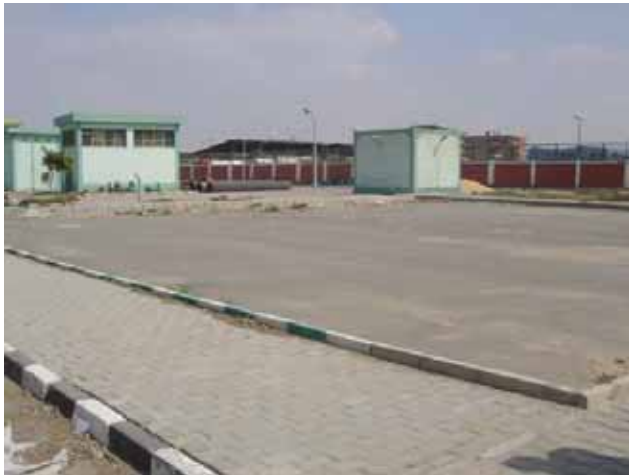
GOGCWSモストロッド訓練センター 漏水探知研修ヤード
