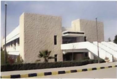
電子サービス訓練センター建屋
