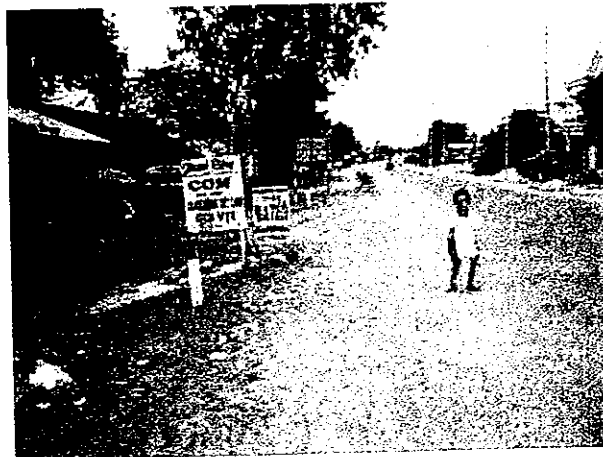
道路拡張計画のあるカイメツサイトからのアクセスの R51 の接続部
