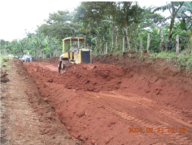
農道整備中(拡幅工事)のブルドーザ； Jinotega
