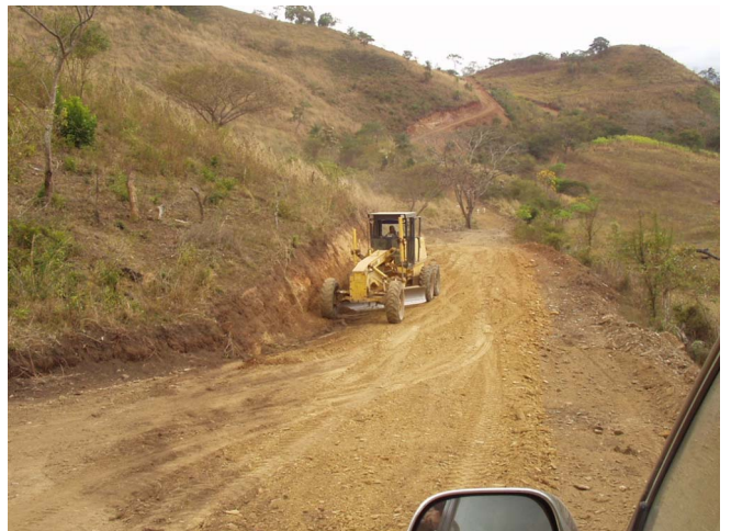
農道整備中(拡幅工事)のモータグレーダ； Nueva Segovia-Palo Prieto
