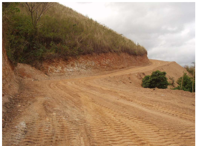
拡幅工事完了直後で砂利舗装前の農道； Wiwili-Jinotega
