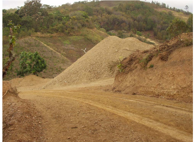
砂利舗装に使用する砕石場;多くは道路沿線の天然砕石を採取する
