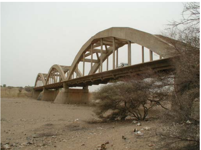
既設エムクル橋 (アスマラ側から望む)
