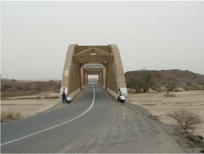
既設ドガリ 1 橋 (アスマラ側から望む)
