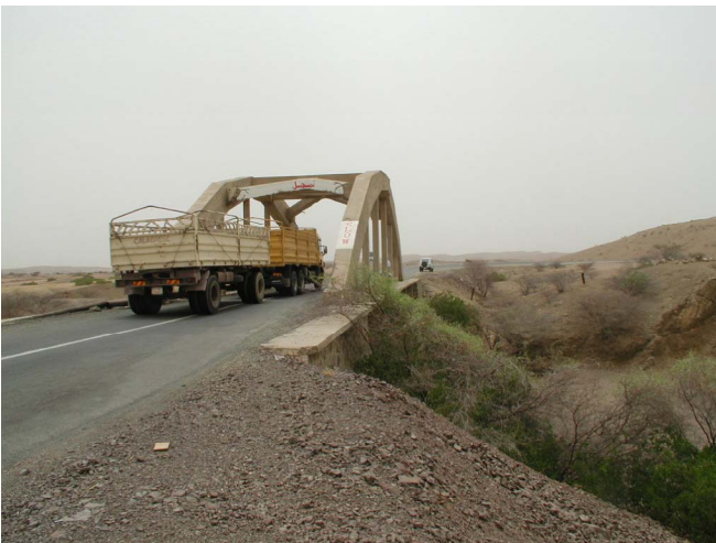
既設ドガリ 2 橋 (アスマラ側から望む)
