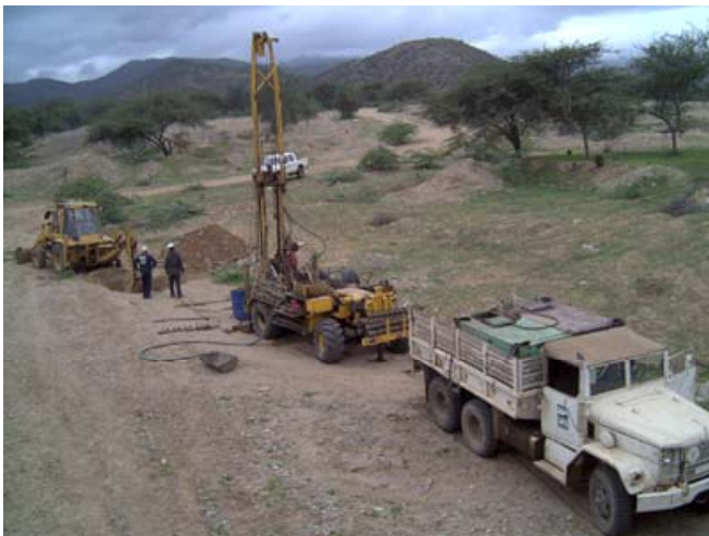
地質調査状況 (ボーリング工)
