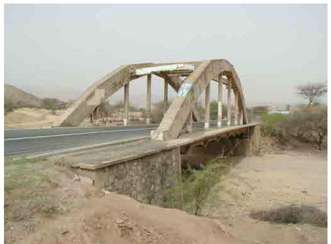
既設ガテライ 1 橋（マッサワ側から望む）
