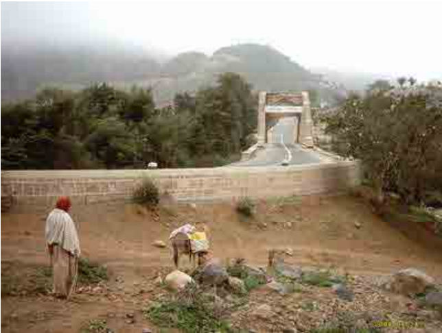
既設ギンダ橋（アスマラ側から望む）
