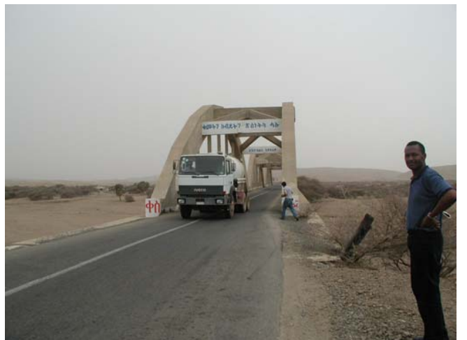
既設エムクル橋 (マッサワ側から望む)
