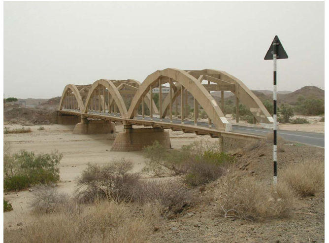
既設ドガリ 1 橋 (アスマラ側から望む)
