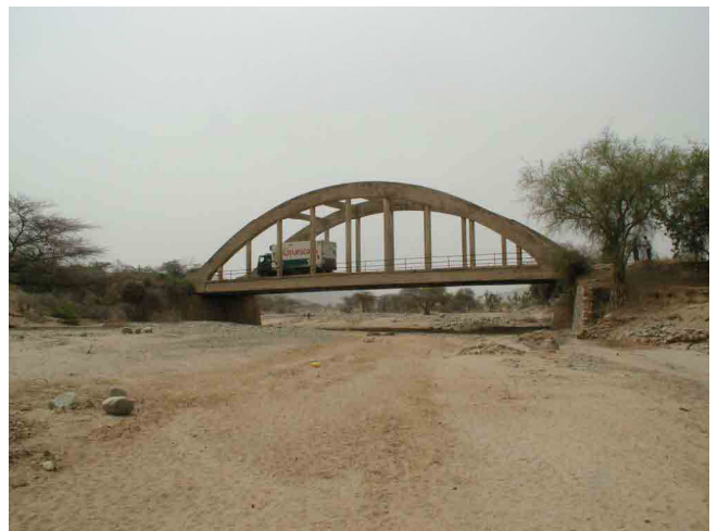
既設ガテライ 2 橋（上流側から望む）
