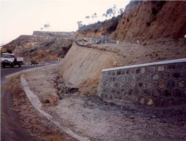
アスマラ～マッサワ道路 アスマラから約 20km 付近
