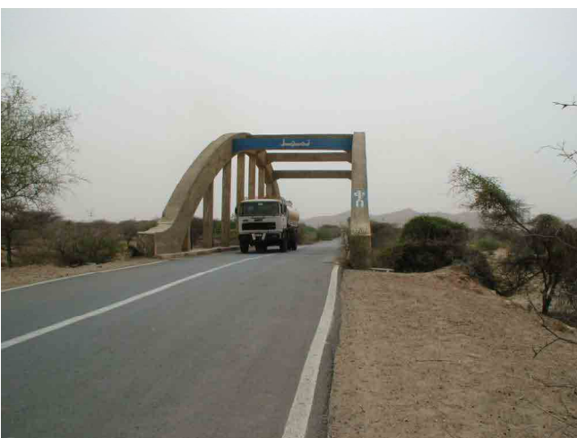
既設ガテライ 2 橋（マッサワ側から望む）
