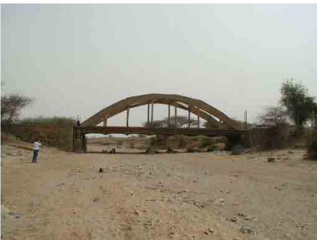
既設ガテライ 1 橋（上流側から望む）
