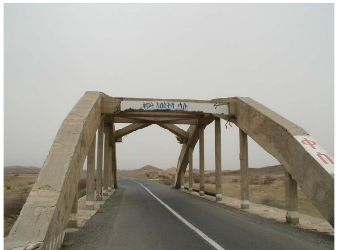
既設ドガリ 2 橋 (マッサワ側から望む)
