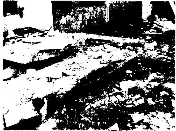
写真 22 落下した PC パネル
