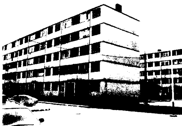
写真 21 壁式構造の建物（無被害）
