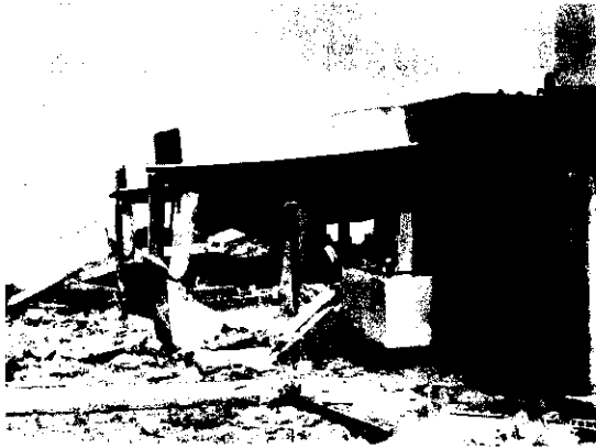
写真7 大破した建物
