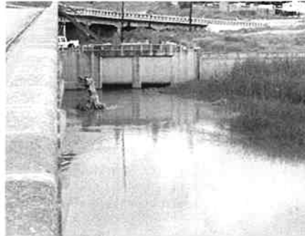
2 マカレタネ堰 旧取水口
