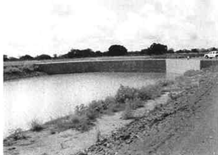
7 水路横断施設No-1 (2/2期工事)
