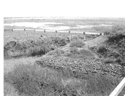
8 同左水管橋付近
