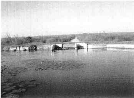
4. 2次給水路分水工(V17-M)
