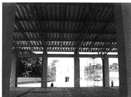
14.卸売市場 卸売場
