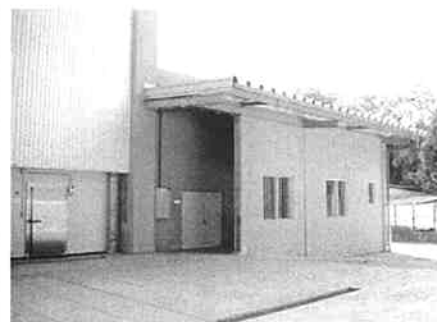
15.卸売市場 貯水庫入口、便所
