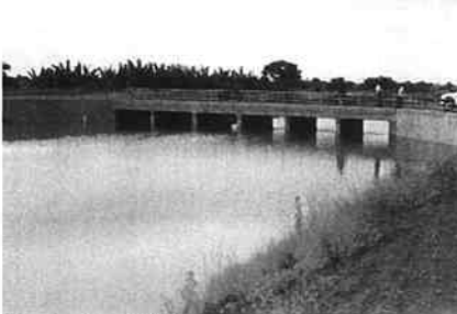
9 同左下流側 左岸管理用道路よりの遠景
