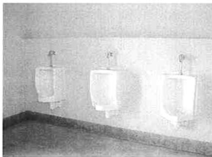
41.公衆トイレ(男子トイレ)
