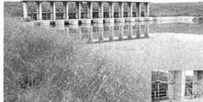
2 取水口 (下部写真はゲート部 ガイド及びスクリーン)
