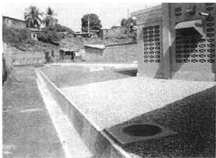
43.受変電・発電器機室 北側
