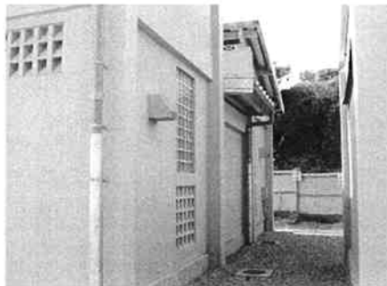
38.公衆トイレ 東側
