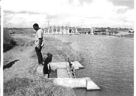
3 一次給水路左岸
