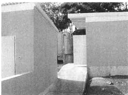
47.ゴミ一時集積場、ポンプ室、 受水槽
