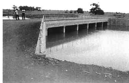
8 水路横断施設No-2 (2/2期工事)
