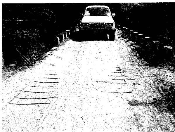
番号：P2270008 日付：2月27日 場所：シャオカイ 北緯： 東経： 標高： 備考：シーパー河を渡る橋、破損して鉄筋が露出。
