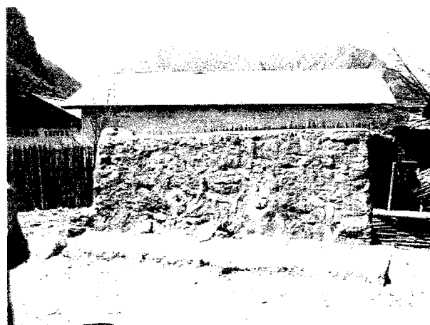
番号：P2250009 日付：2月25日 場所：タウシュエ 北緯： 東経： 標高： 備考：村の配水タンク
