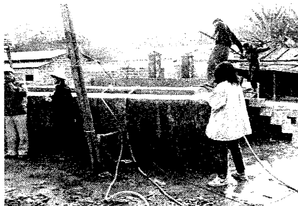
番号：P2220003 日付：2月22日 場所：パッサンジョー 北緯：23/36/14 東経：98/47/49 標高：990m 備考：ロートンコーからの給水、配水用のタンク
