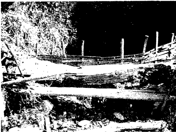
番号：P2170014 日付：2月17日 場所：チャー河 北緯： 東経： 標高： 備考：湧き水取水用構造物、竹と土で住民が建設
