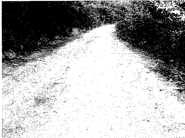
番号：P2180023 日付：2月18日 場所：マンロー 北緯：23/44/21 東経：98/40/24 標高：1,990m 備考：道路状況の良い所、表面碎石舗装が残っている。
