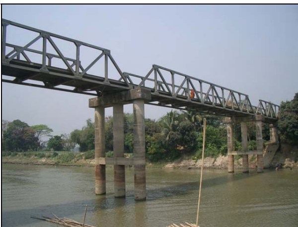
写真 5-5 メグナ河に架かる 08-04-03 橋。
