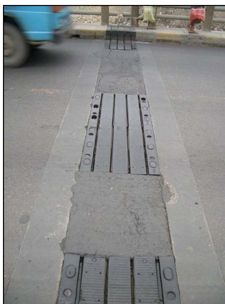
写真 2-6 ジョイント部分は、アスファルトにより補修されている。(メグナ橋も同様である。)
