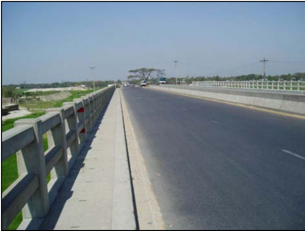
写真 3-1 アシヤルチャー1 橋の路面状況。
