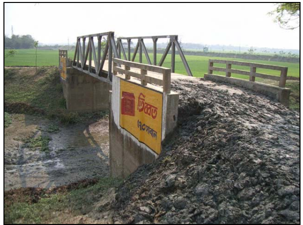
写真 5-4 ダッカーチッタゴン幹線道路に接続する 08-02-02 橋。
