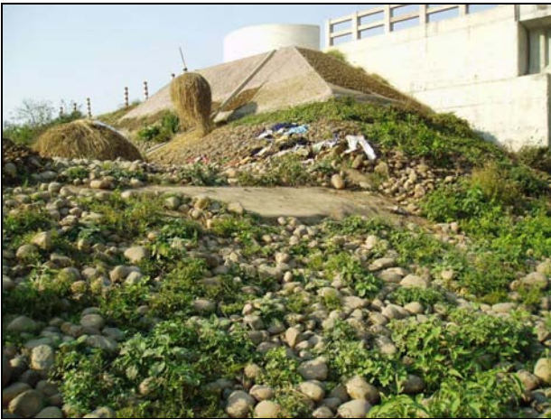
写真 3-3 マディヤバウシア橋の蛇かごの現況。
