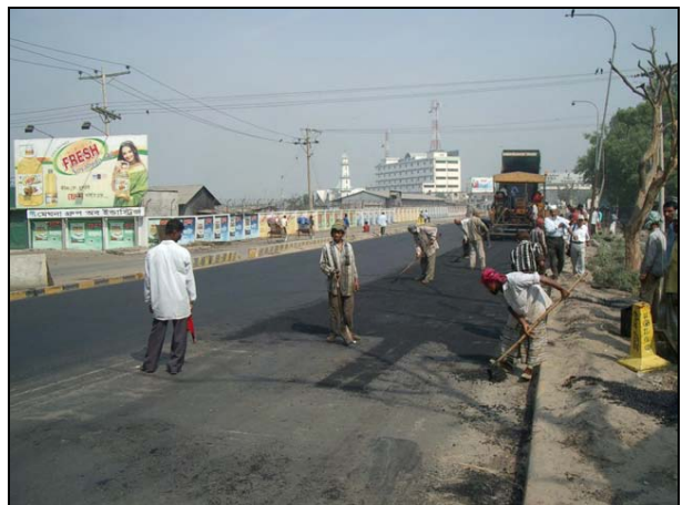
写真 1-6 ダッカ側アプローチ道路の改修を行っている。
