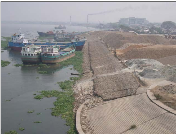
写真 1-5 左岸側の護岸の蛇籠の状態は良好である。
