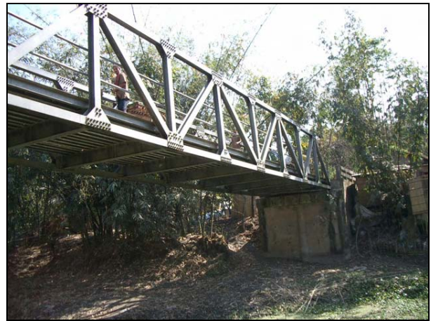
写真 4-2 ダッカーアリチャ道路（国道 5 号線）に接続する 13-03-02 橋。
