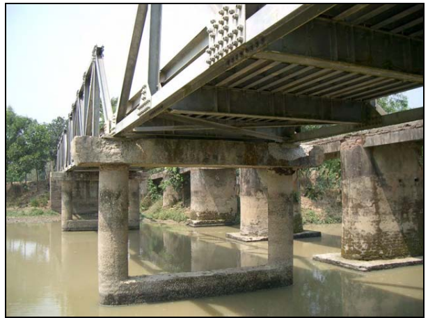
写真 5-2 旧橋と平行して架かる 08-01-03 橋。
