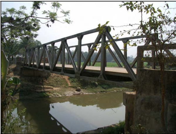
写真 5-1 インド国境から 500m に位置する 08-01-01 橋。
