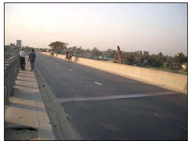
写真 3-6 マリカリ橋の路面状況。
