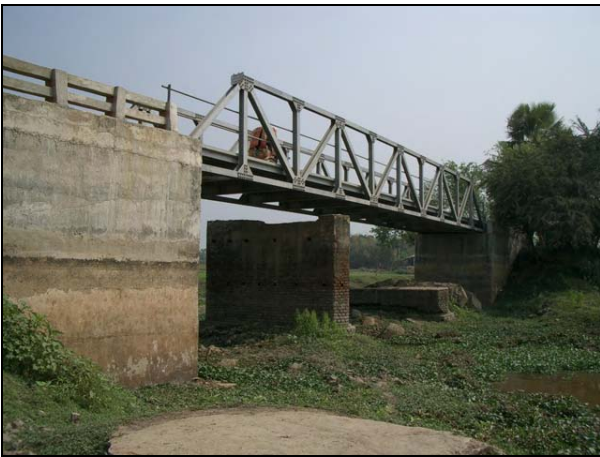
写真 5-3 旧橋の橋脚が残る 08-02-01 橋。
