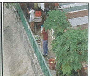
トータルステーションによる洗掘位置測定
