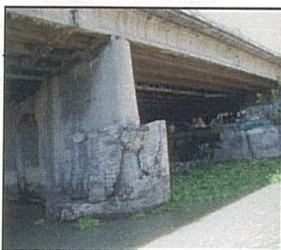
フーティングに取り付けた RC 防舷材タイプ (グアダルーペ橋)
