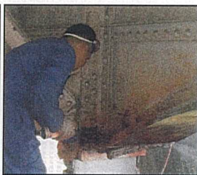
浸透探傷試験
