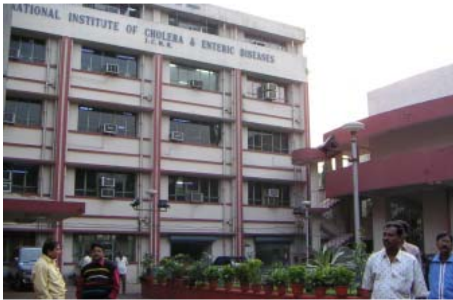
既存 NICED の施設外観
