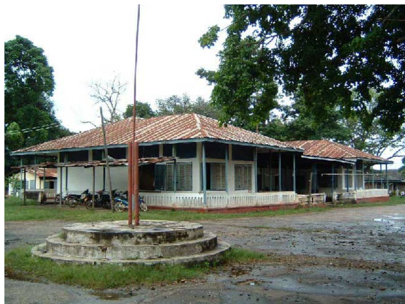
大教室棟：ラオス国側にて学生寮へ改修予定
