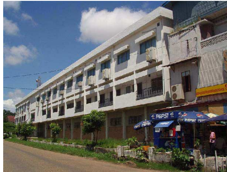
管理・教室棟：2002年に3階部分を増築。
