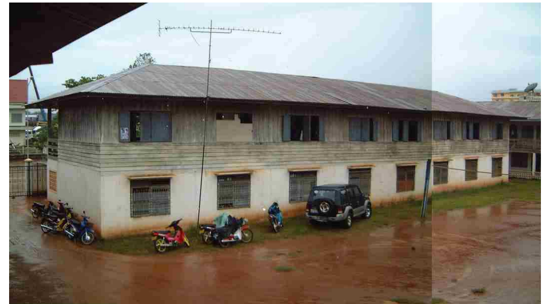
実習室・学生寮棟：1980年に建設され、その後1階ピロティ部に壁を増設し、現在の2階建てとなる。1階は鉄筋コンクリート造、2階は木造。本件で改修予定。
