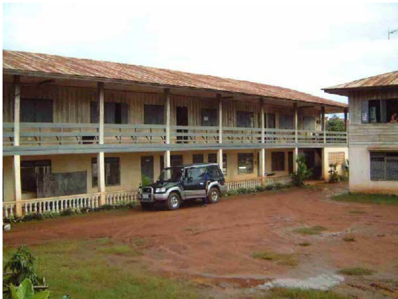
教室・学生寮棟：実習室・学生寮棟と同じ経緯で建設された。
