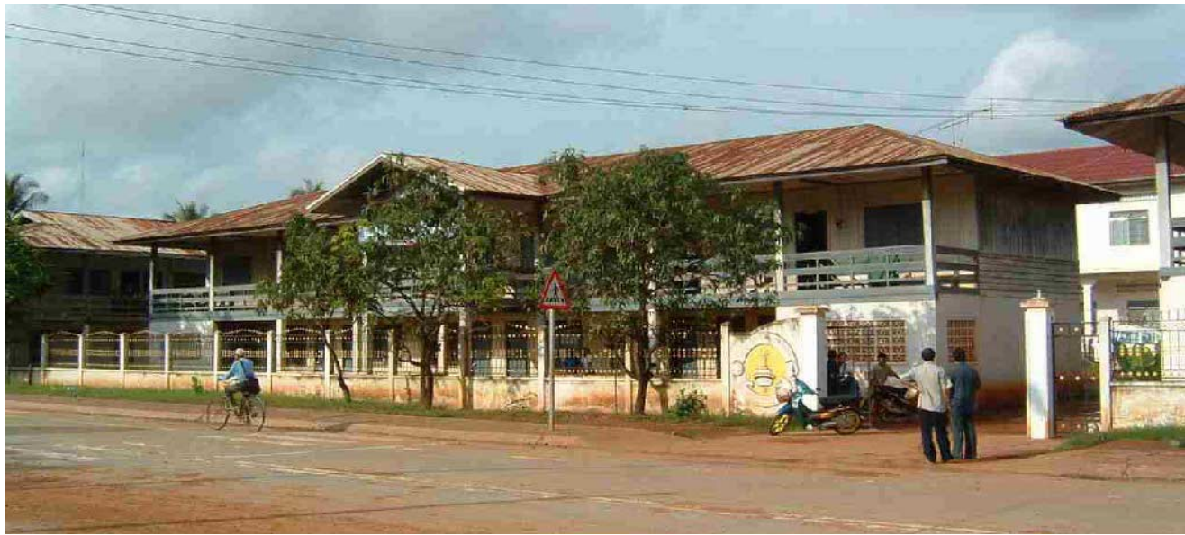
実習室・学生寮棟：1980年に建設され、その後1階ピロティ部に壁を増設し、現在の2階建てとなる。1階は鉄筋コンクリート造、2階は木造。本件で改修予定。
