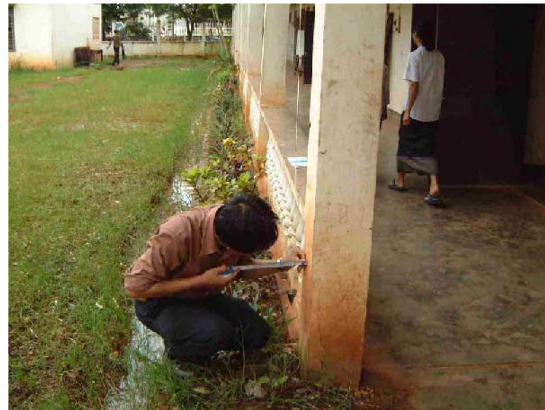
教室・学生寮棟：1階床レベルと地盤面が同じ高さ
