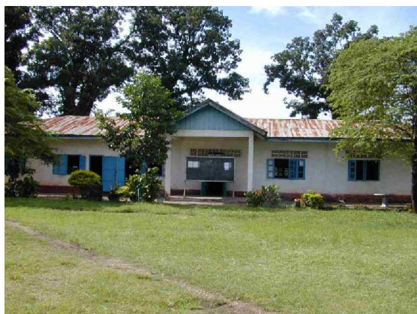
会議室棟：実習室、図書室、会議室他で構成される。
