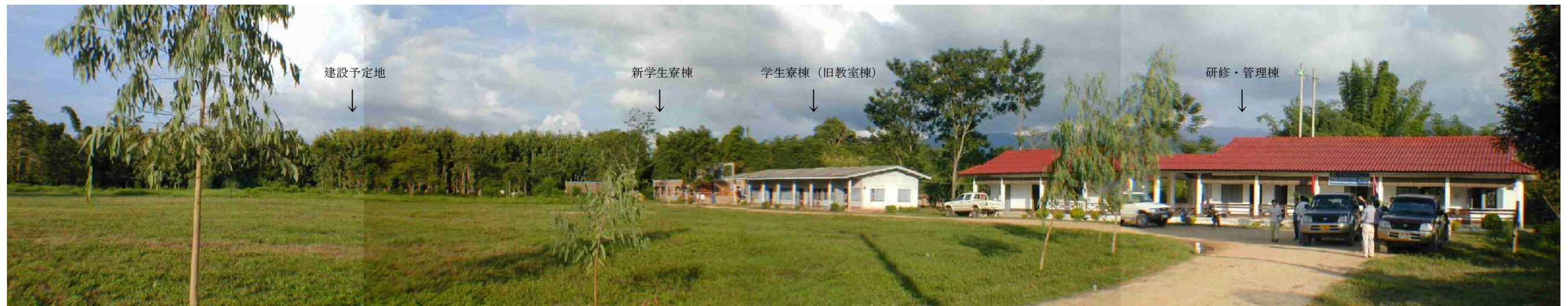
敷地全景：右側より研修・管理棟、学生寮棟（旧教室棟）、新学生寮棟が並ぶ。左側の空地为新教室棟の建設予定地。
