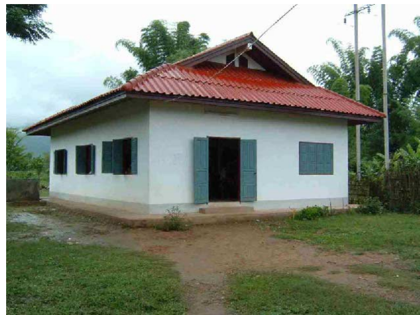
食堂：教室不足のため、一時的に教室として使用されている。
