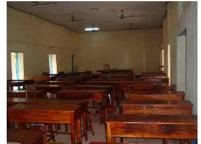
教室棟内部：開口部は出入口のみで薄暗い。
