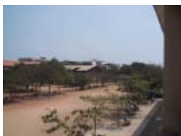
計画施設の建設予定地 解体撤去対象の老朽校舎は、上部躯体のみ撤去済み。基礎部分は残存。
