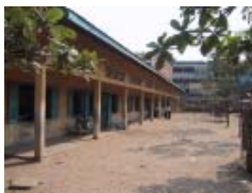
平屋建て教室棟
