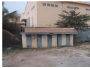
生徒用便所 現在使用されていない。解体撤去予定
