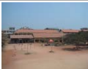
平屋建て教室棟
