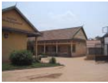
平屋建て教室棟
