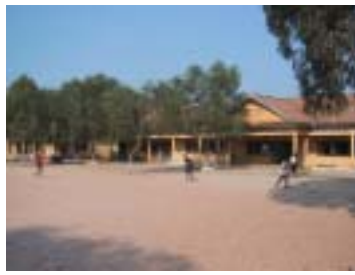
平屋建て教室棟
