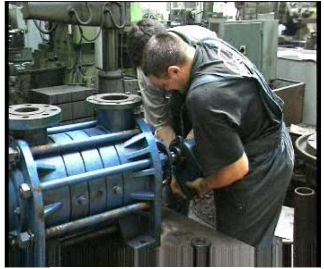
配水（遠心）ポンプの修理(2)
