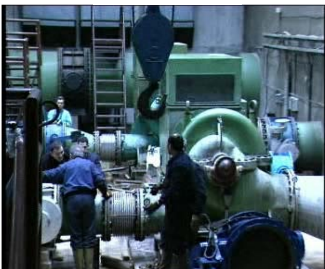
配水ポンプの据え付け
