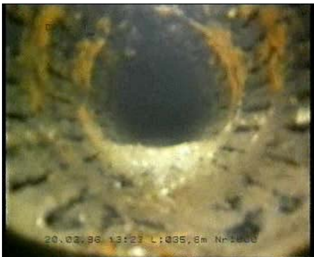
Reny Well の水平多孔集水管のリハビリ(作業前)
