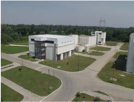
マキシユ浄水場全景 (BVK 提供)
