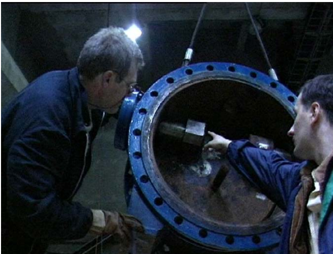
フラップ弁の修理
