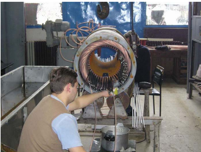
水中ポンプの修理
