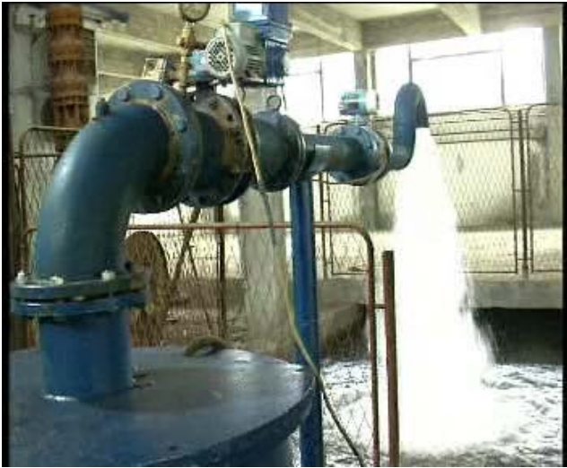
水中ポンプ作動試験(1)
