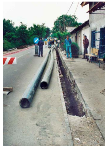
配管工事 (BVK 提供)
