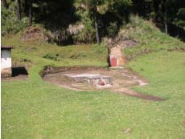
湧水モリノビエホの集水坑(ギャラリー) 当地区には山腹に10箇所の集水坑が並んで存在する。 入口は鉄扉で防護されており、管理状態は良好。総湧出量は110ℓ/秒程度。
