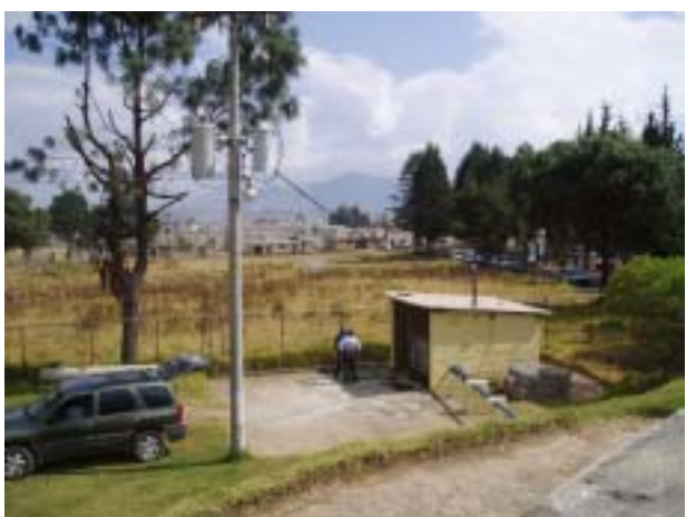
井戸サンイシドロ (1989 年建設) 井戸深 187m、口径 \phi 200mm、揚水量 13 ㍈/秒。サンイシドロ配水池に送水している。
