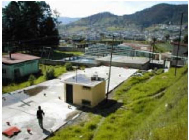
チリエス配水池 都市部の東部域配水システムの要となる配水池。本計画では対象外となったが、将来は送水ポンプ場を建設しロサリオバホ、コロニアモリーナ等配水池への送水の拠点となる。
