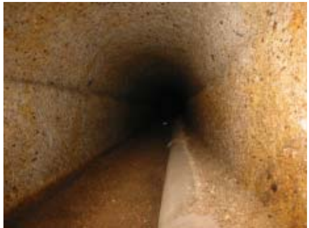
湧水導水路トンネル内部 トンネル側底部に導水管ACφ450mmが布設されている。徒歩でサンイシドロ配水池側の出口まで通行が可能。管路に空気弁の設置を計画する。
