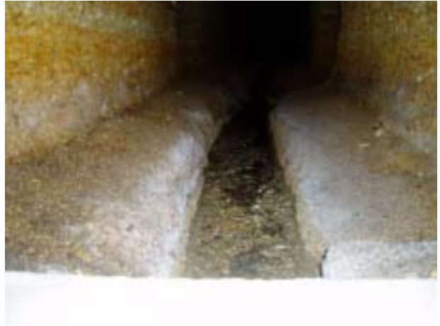
湧水モリノビエホのギャラリー内部の集水路 坑内は幅1m、高さ2.2m程度、坑壁は粗い砂質凝灰岩。幅30cm程度の水路に湧水が集水されている。
