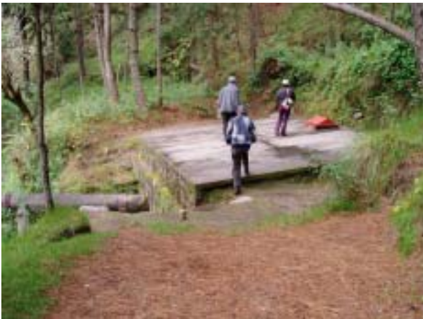
湧水シエテチヨロスの湧水集水地点にある集水樹 総湧出量は38ℓ/秒程度。
