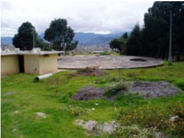
サンイシドロ配水池 有効容量 2560 m 3 、直径 24m、有効水深 5.5m の既存配水池。全ての湧水が本既存配水池に導水されている。配水システムの要となっており、さらに 1,140 m 3 の拡張と、ソナメディア配水池向けの送水ポンプ場の建設を計画する。
