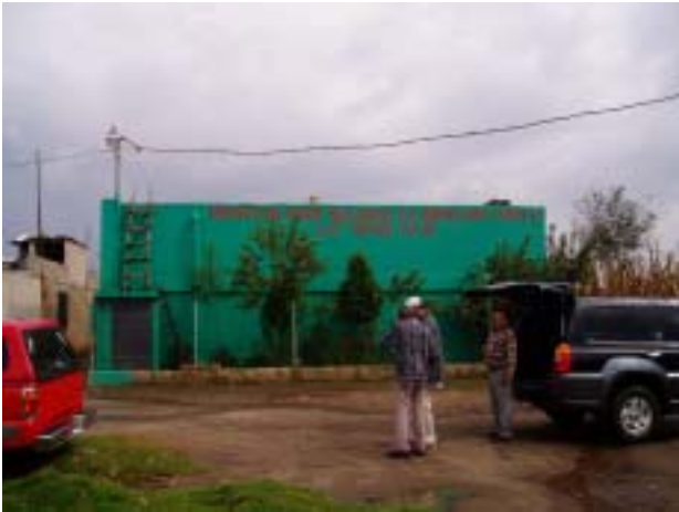
井戸と配水池チプレサーダ(1994年建設) 井戸深 183m、口径φ200mm、揚水量 34ℓ/秒。地区委員会が管理。計画では EMAX に管理を移管し、余剰水をサンイシドロ配水池に送水する。配水池容量 670m 3 。
