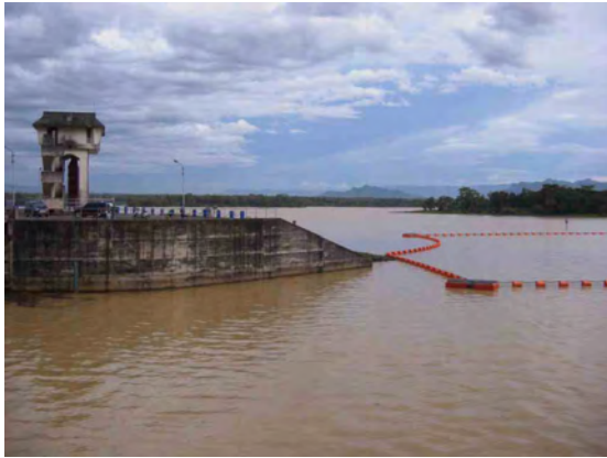
写真 1 : ダム軸付近 ( 1 ) 左岸より Kuduang 川方向を望む。
