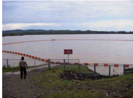
写真 2 : ダム軸付近 ( 2 ) 左岸付近より貯水池縦断方向を望む。
