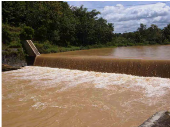
写真 5 : 砂防ダム ( Kuduang 川 )
