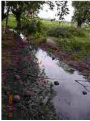
マナー県ため池の取水口そば用水路。以前修復されたらしいが、維持管理が行われていない。
