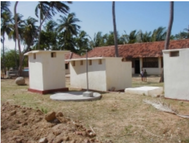
同小学校のトイレと浄化槽の建設。ADBのNECORD事業が拠出。
