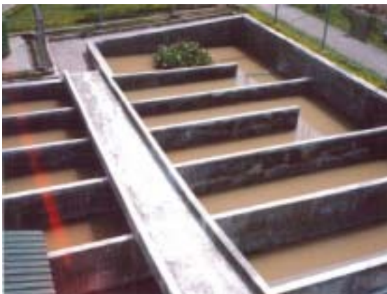
自然流下で空気と触れさせる
