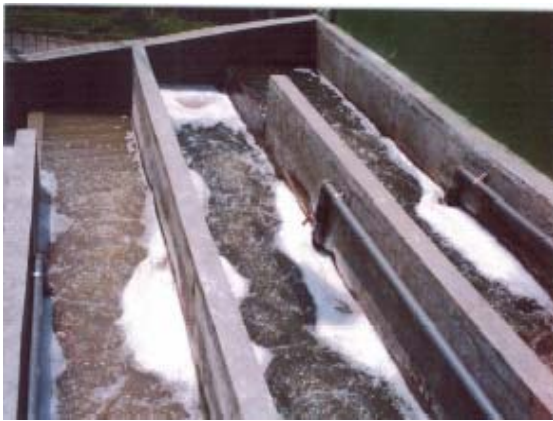
処理済の水に空気を吹き込む
