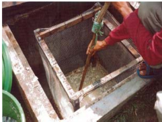
パイプラインで運ばれてきた不純物を施設に入る前に除去している
