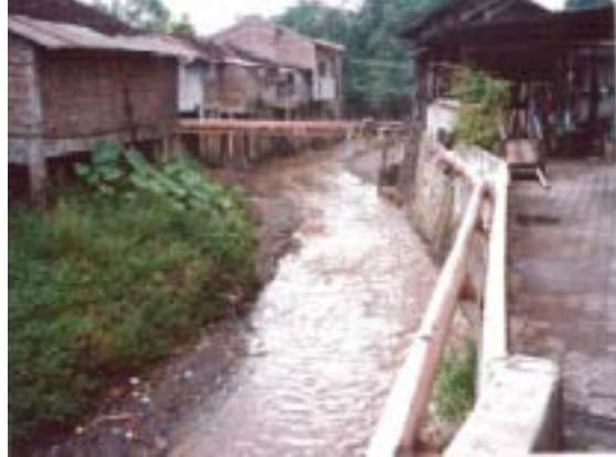
河川脇のパイプライン
