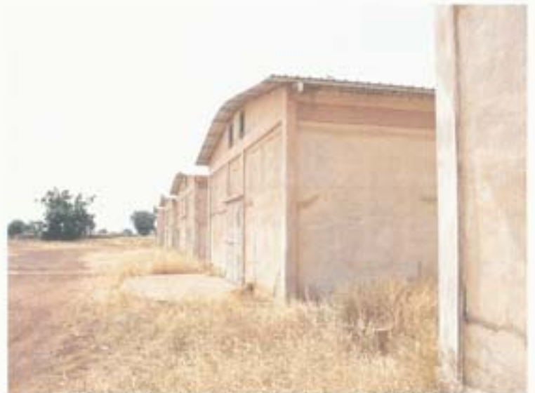
肥料の保管に使用したセグー市内の食糧保管倉庫 肥料は出荷済みで在庫は無い
