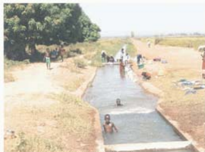
灌漑地内の支線水路の状況 (洗濯場や遊び場として利用されている)
