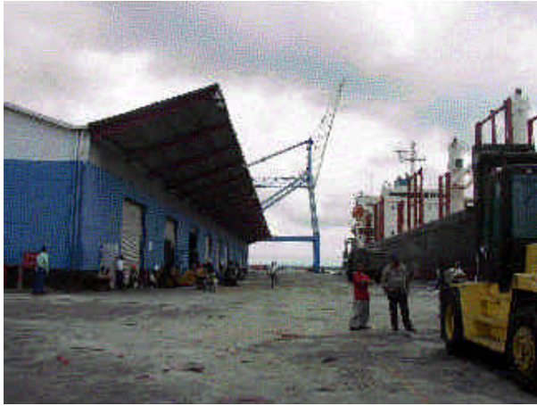
写真1 2KR 資機材が到着するコリント港。埠頭は4バースで、「ニ」国最大の貿易港である。資機材はトラックで35km先のIDR テリカ倉庫まで運ばれる。
