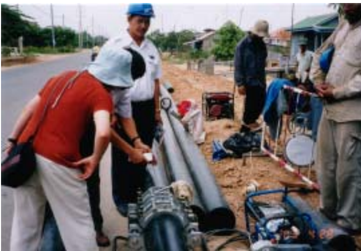
プノンペン市水道局 管網敷設工事現場(郊外)
