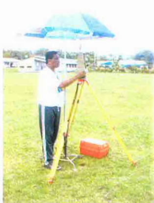
地形調査立会い。プロジェクトサイトは南側から北に向けて緩やかに下る地形で、長手約 400mに対して20mの高低差がある。
