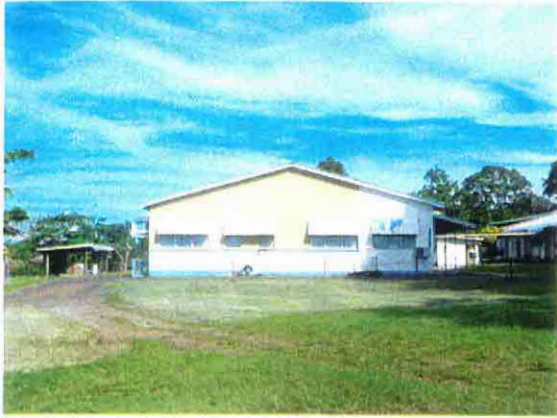
築 35 年以上の SP 内で最も古い校舎。現在は製図室・コンピューター室・一般教室が入っている。
