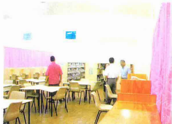
図書室。比較的状态が良好な為本プロジェクトでは改修対象とした。
