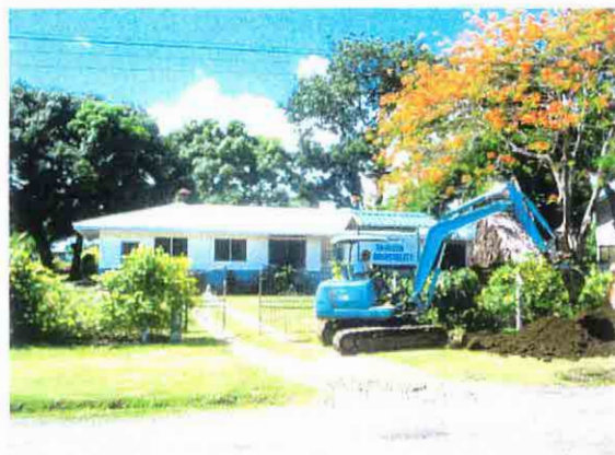
バイパス通りに面した観光・接遇科校舎。住宅を改造したものの為、使い勝手が悪く老朽化も激しい。本プロジェクトでは正門の位置となる。
