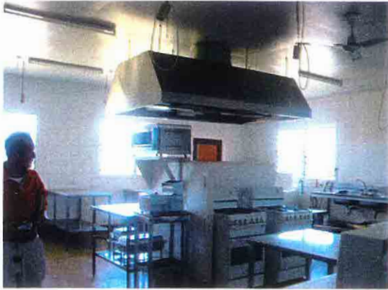
観光・接遇科厨房。よく整理され、清潔が保たれている。
