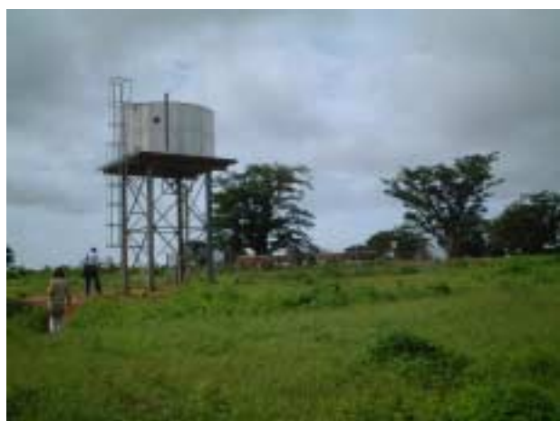
Aljandu : EDF ソーラー揚水システム ( 1.98kw , 44m 3 / 日 )
