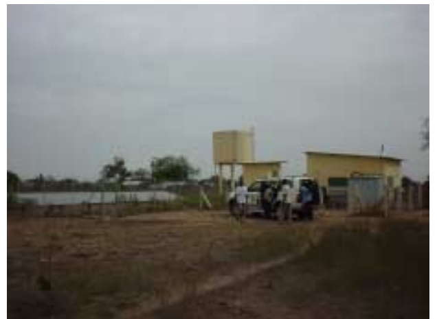
Ndung Kebeh : 本邦無償資金協力により建設され た給水施設の稼動状況 ( ソーラー揚水システムに 改修され稼動中 )
