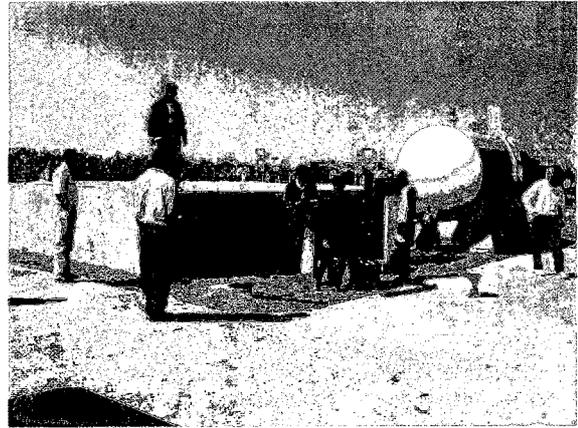
チオンベの半埋設貯水槽と給水車用燃料タンク
