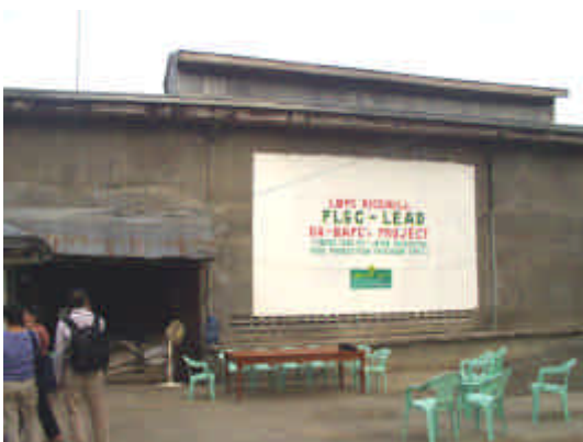
写真5 見返り資金によってつくられた精米所倉庫（パナイ島「ライスセンター計画」）
