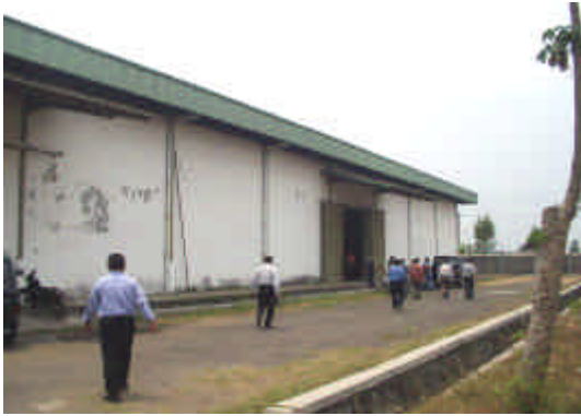
写真3 東ジャワ州 PUSKUD 倉庫 2KR 調達肥料が保管されている。
