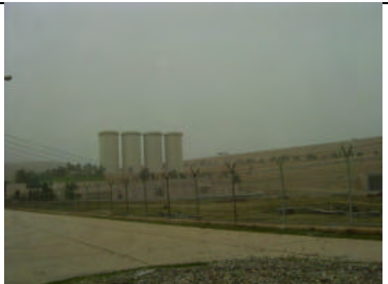
モスル水力発電所 サージタンク。
