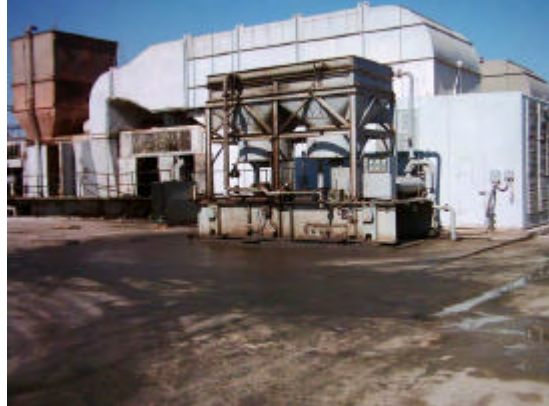
撮影 2003年3月 モスルガスタービン発電所 (2号機) 減速ギア振動のため停止中。
