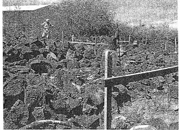
海事資源ユニット増設工事現場 現場内は資材の運搬、コンクリート打設も手作業で行われる。
