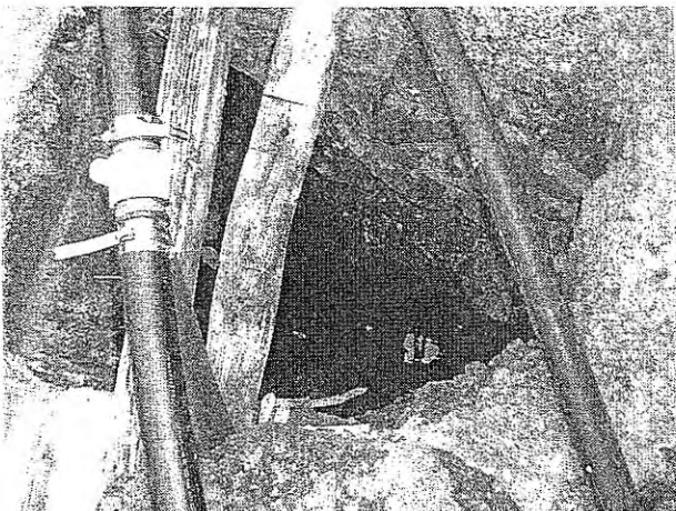
水源地 ガラパゴス公園敷地内において、岩の間に地下水を揚水ポンプにてくみ上げ、貯水タンクに送る。水は塩分を含むため、直接飲料、工事用水に使用できない。
