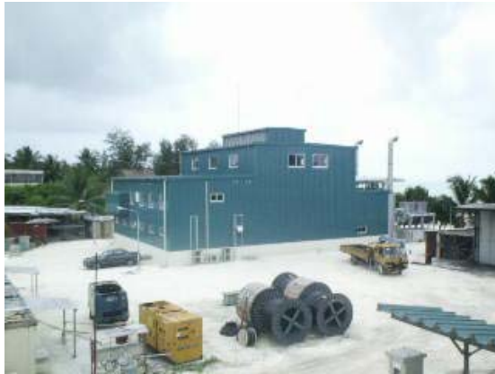
新（中央）および旧（右端）発電所建屋
