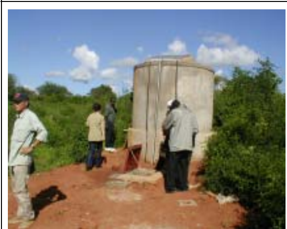
写真-11 既存設備（ソーラーによる給水）
