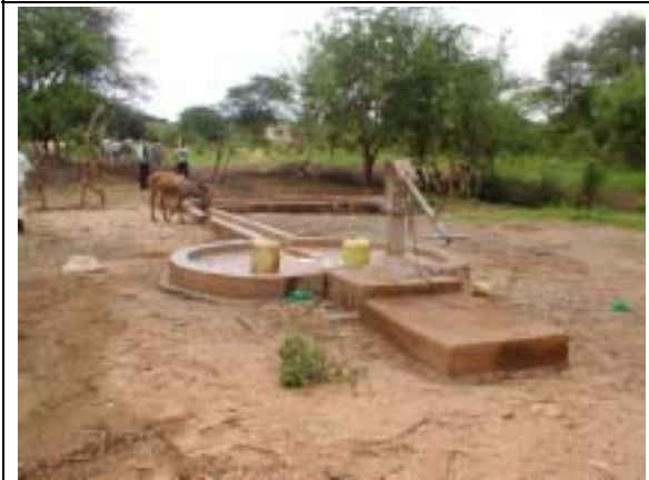
写真-9 既存水源（ハンドポンプ）
