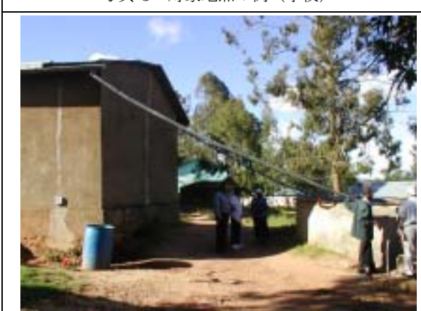
写真-5 既存水源（ルーフキャッチメント）
