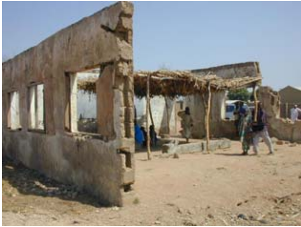
Ungwa Hausau LEA 校： 倒壊した校舎地に仮設教室を作り授業が行われている。
