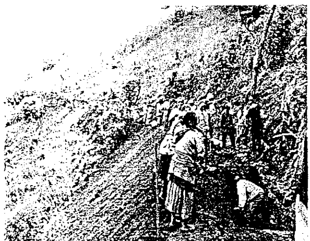
(写真 A4 : 明るく賑やかな導水路作業)
