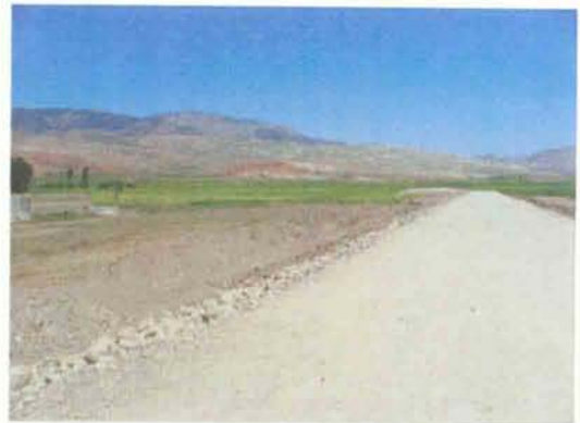
ダシュト村上流に建設中の堤防
