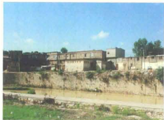
ネッカ川で洪水後に設置された護岸 (ネッカ市内)
