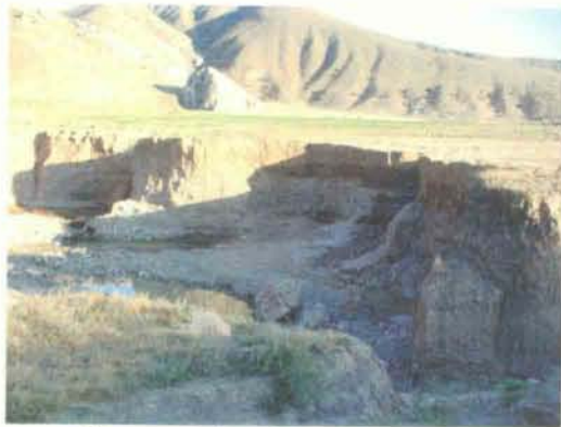
ダシュト村下流の河道浸食状況
