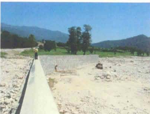
洪水後設置されたマダルス川護岸 (タンゲラ村付近)
