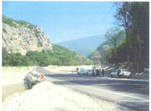
マダルス川中流域で復旧した道路 (ゴレスタンの森内)
