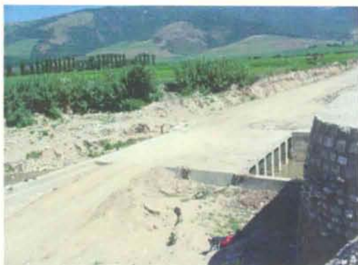
マダルス川下流の洪水時に流された橋 の脇に設置された取り付け道路
