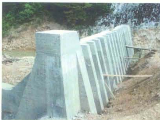
ネッカ川中流に建設中のスリットダム (JICA 専門家の技術指導により建設)
