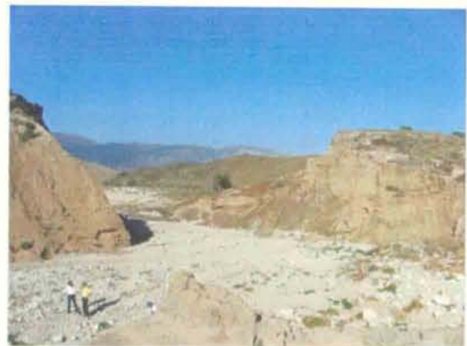
ダシュト村上流の決壊した土ダム
