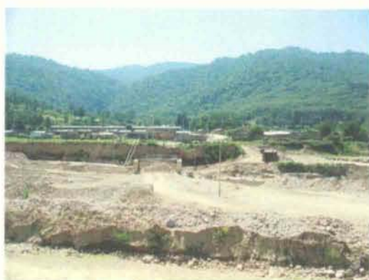
マダルス川下流 ローバー村入口 (橋の復旧工事中)
