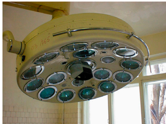
バルブが 3/1 切れている無影灯
