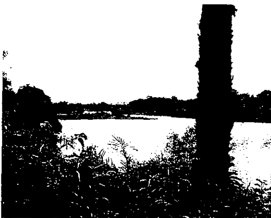
5. 貯水池（堰堤からの様子）
