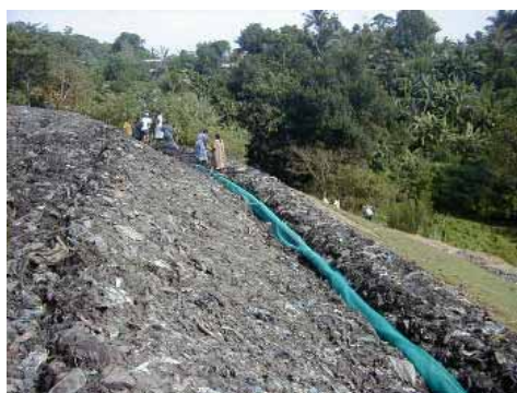
浸出水収集施設
