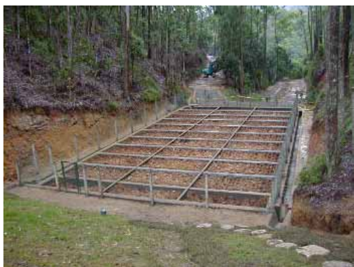
浸出水処理施設
