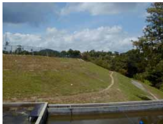
改善後処分場法面
