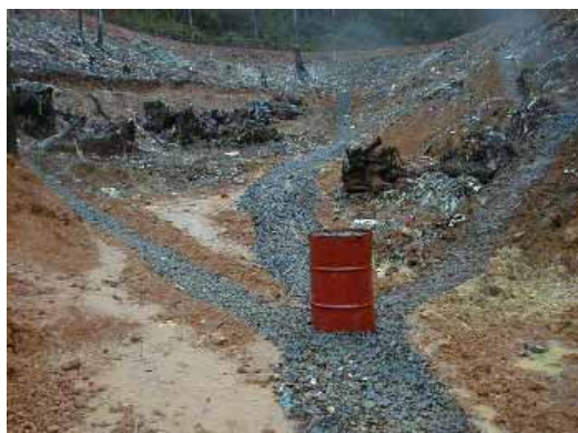
ガス抜き施設
