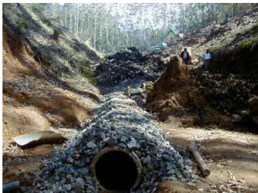
浸出水収集施設
