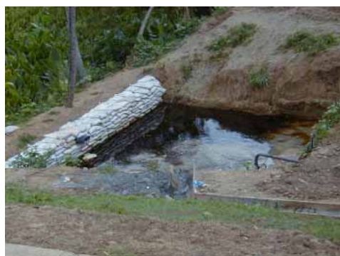
浸出水収集池
